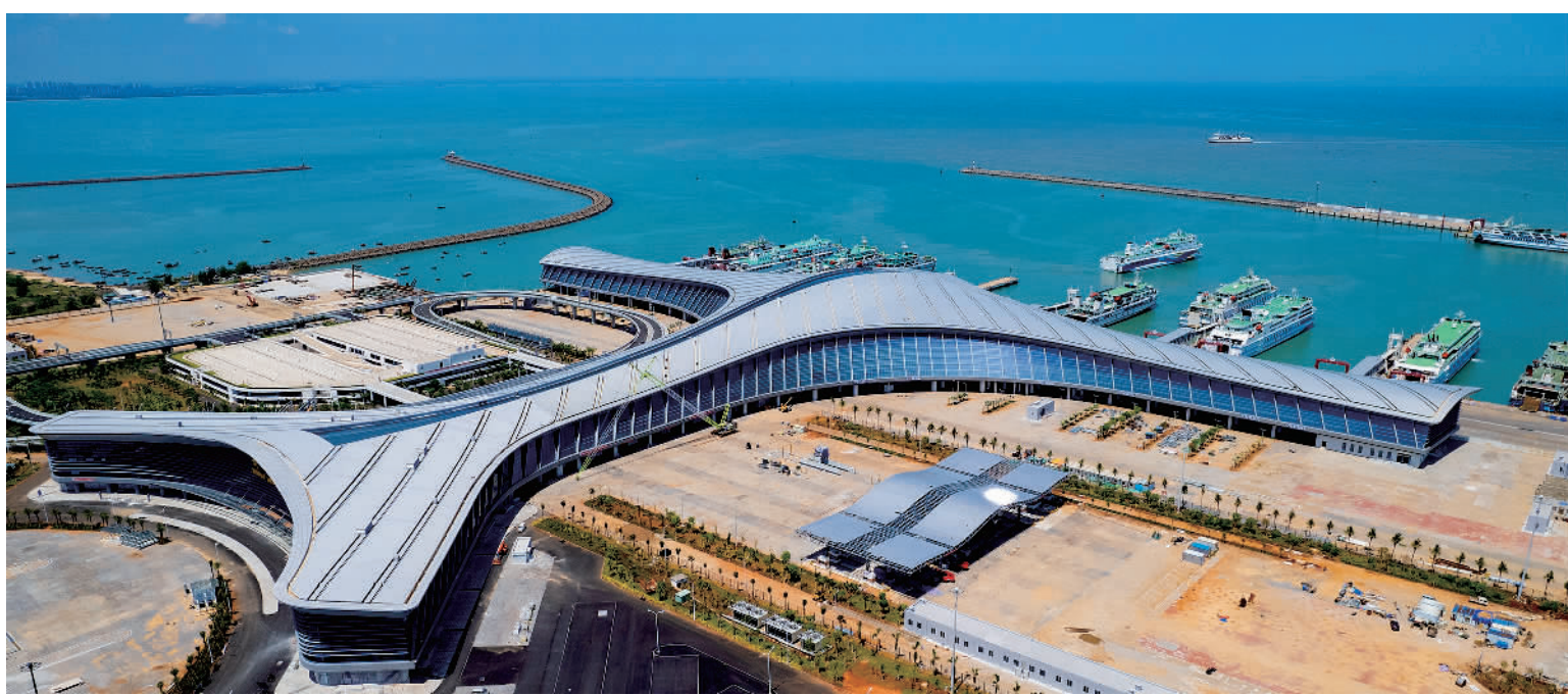
8月17日，俯瞰进入建设收尾阶段的海口新海港综合交通枢纽站项目。该项目建成后，将成为全国最大港口客滚综合枢纽，通行承载能力可达到每年通过旅客3500万人次、车辆560万辆次。张俊其摄(中经视觉)
