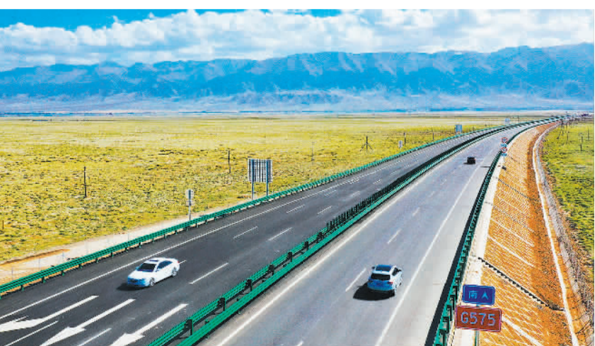
9月1日,新疆G575老爷庙口岸至巴里坤公路二期工程建成通车,该公路成为贯通天山南北交通大通道的重要组成部分。 普拉提·尼亚孜摄(中经视觉)
