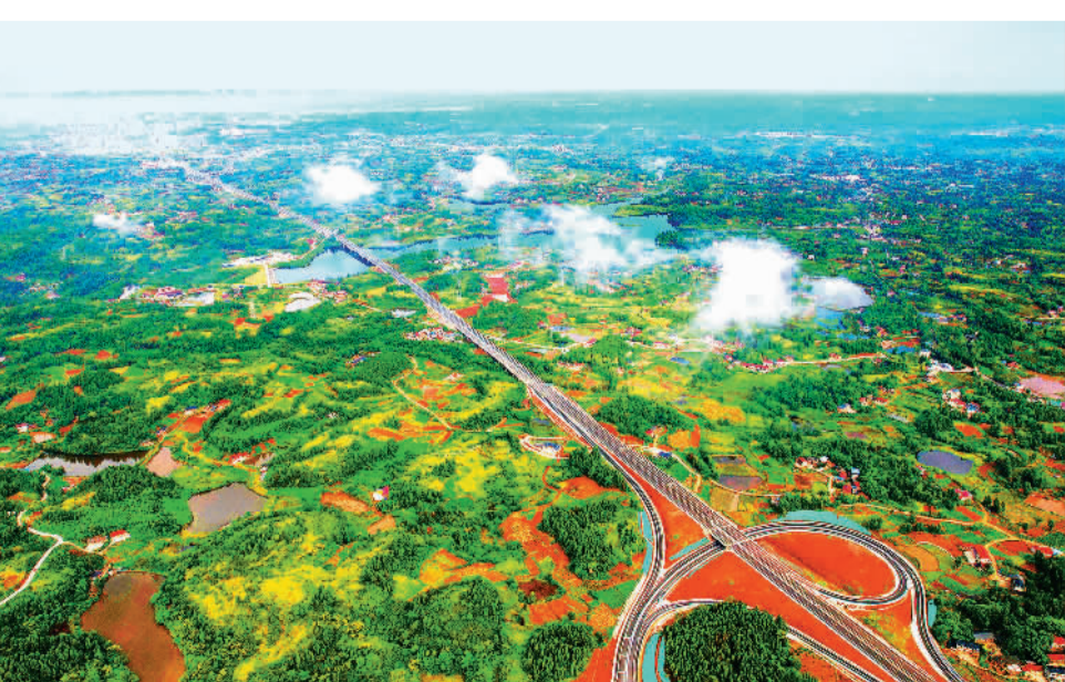
9月13日,从空中俯瞰内大高速公路四川省内江市东兴区段。内大高速公路四川段顺利完工并通过验收,实现全线贯通。该高速公路是川渝合作重点交通项目之一,起于四川省内江市东兴区,止于重庆市大足区。 兰自涛摄(中经视觉)
