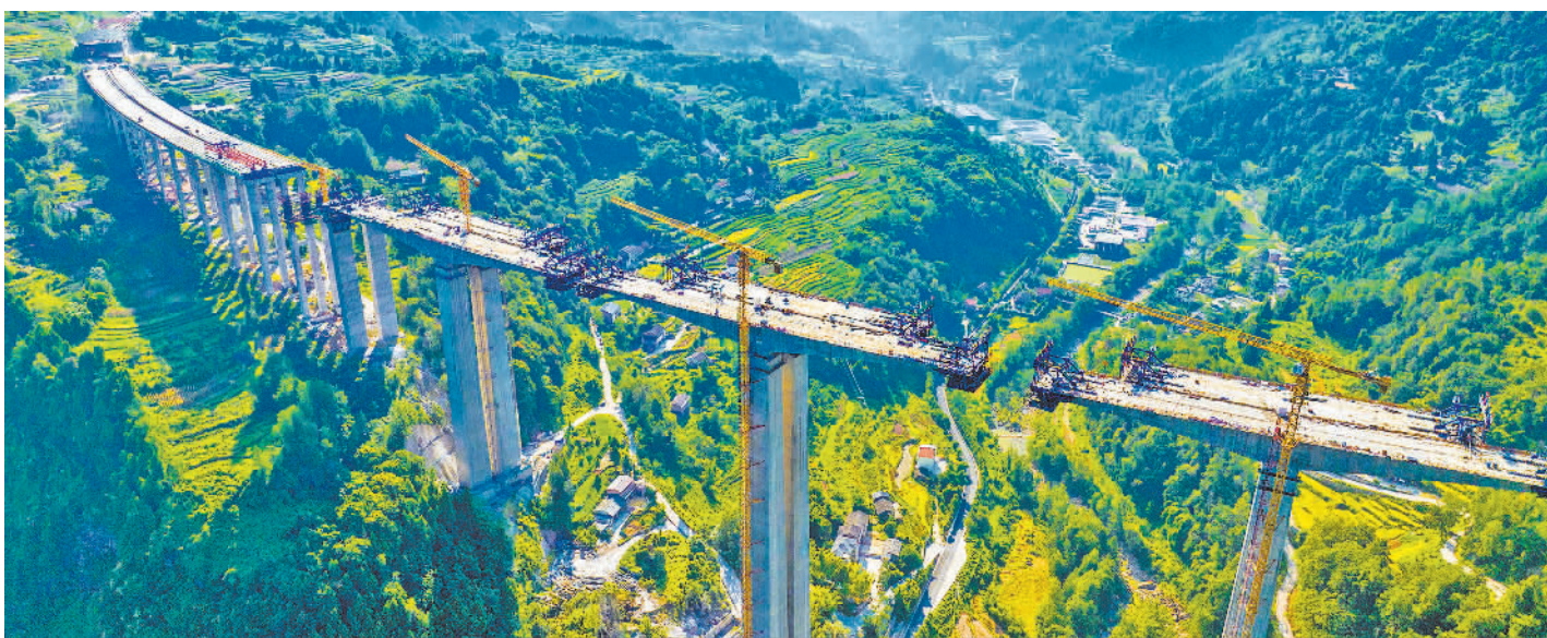
9月17日，建设中的渝湘复线高速龙川江特大桥。大桥全长1350米，跨越低山河谷，施工现场地形地势复杂。目前主桥已开始挂篮悬臂施工，计划于今年11月底完成全幅合龙。 胡 波摄(中经视觉)
