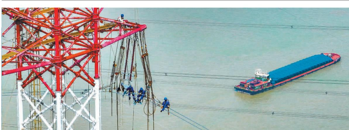
9月26日，在国内首个“交改直”输电工程现场，江苏省送变电有限公司施工人员正在百米高空跨越长江进行导线更换。该工程作为我国新型电力系统试点工程，建成后将显著提升长江两岸电网互联互通能力，更好促进长三角区域间能源的高效流动。
