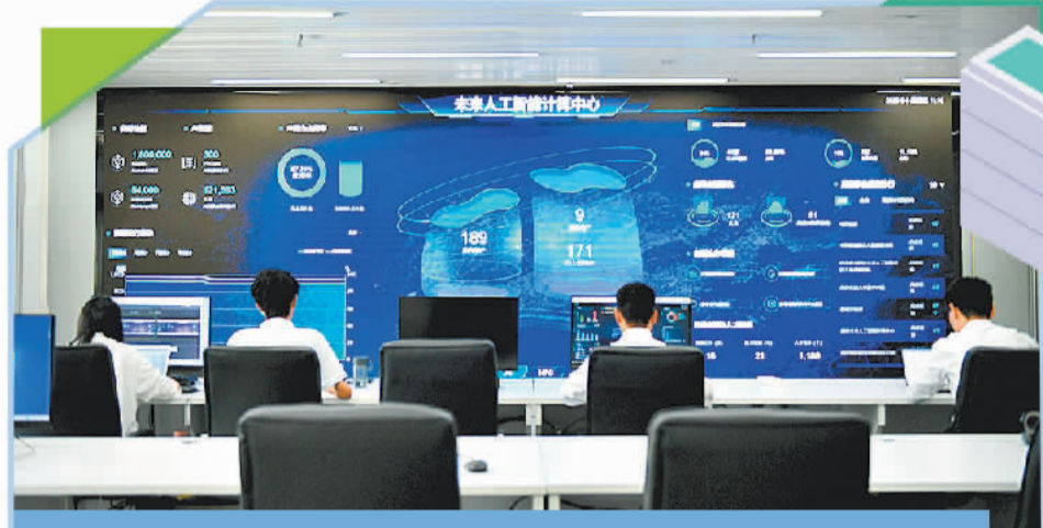
在陕西省西安市雁塔区未来人工智能计算中心监控运维室,工作人员通过智慧大屏监测平台运行情况。该中心是我国西部首个大规模人工智能算力集群,目前投产的算力居全国第二位。
