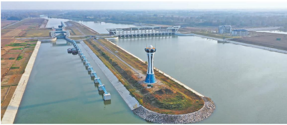
10月24日，俯拍安徽省亳州市蒙城县涡河蒙城枢纽的天气雷达。该项目为中国气象局2022年气象监测预警补短板工程，雷达塔楼设计高度38米，顶部造型寓意“蜻蜓之眼”。
