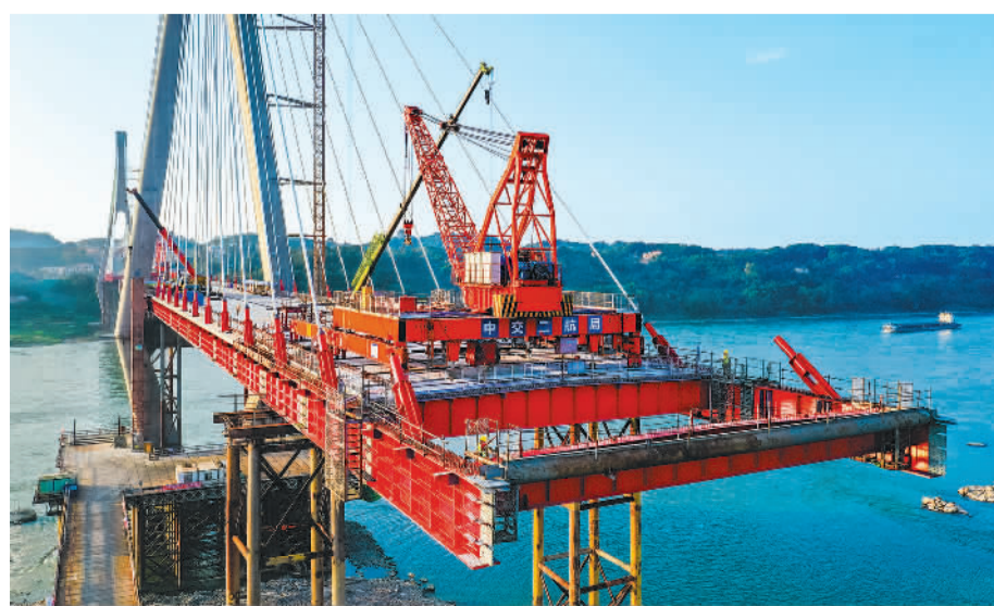
10月29日,四川省泸州市榕山长江大桥钢梁吊装加紧建设。该大桥预计明年通车,通车后将进一步推动泸州交通与重庆毗邻地区互联互通,有效融入成渝地区双城经济圈。 李贵平摄(中经视觉)
