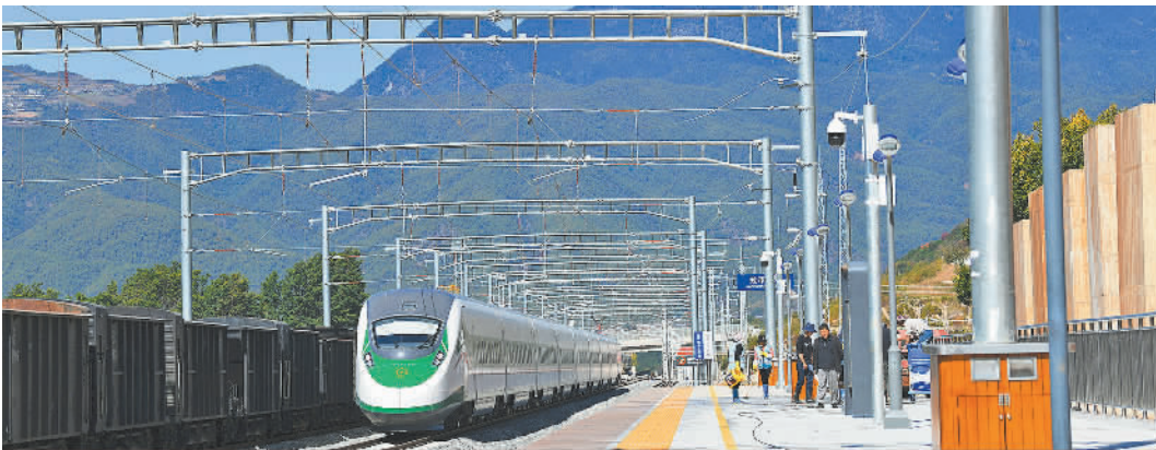
11月9日，动态检测列车在滇藏铁路丽香段上行驶，这标志着滇藏铁路丽江至香格里拉段步入工程验收关键阶段。按照计划，滇藏铁路丽香段有望年内实现全线通车。
