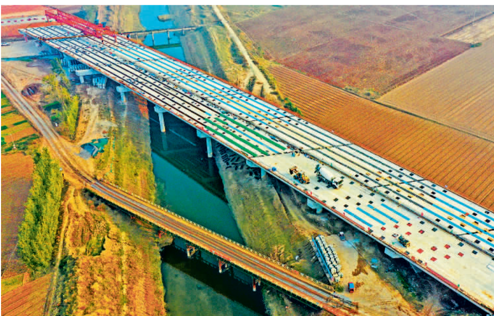
11月13日，河南省沿黄高速公路孟州市谷旦镇赵庄改河工区施工现场。沿黄高速公路项目是河南高速公路“13445重点工程”，项目路线全长100.139公里，计划于2024年底建成通车。白水平摄(中经视觉)
