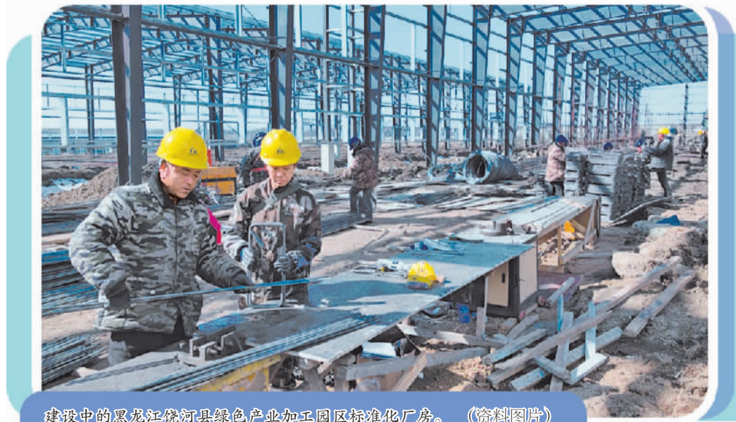
建设中的黑龙江饶河县绿色产业加工园区标准化厂房。(资料图片)
