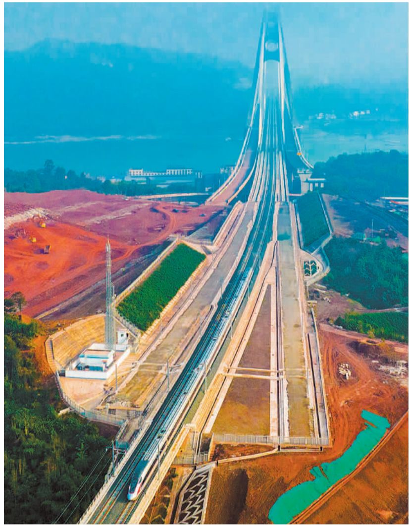
11月19日，一列复兴号动车组试验列车从四川宜宾临港长江公铁两用大桥上驶过。当日，成都至宜宾高速铁路进入运行试验阶段。该铁路为国家“八纵八横”高速铁路网“京昆通道”的重要组成部分，建成通车后将有效带动沿线经济社会发展。(中经视觉)
