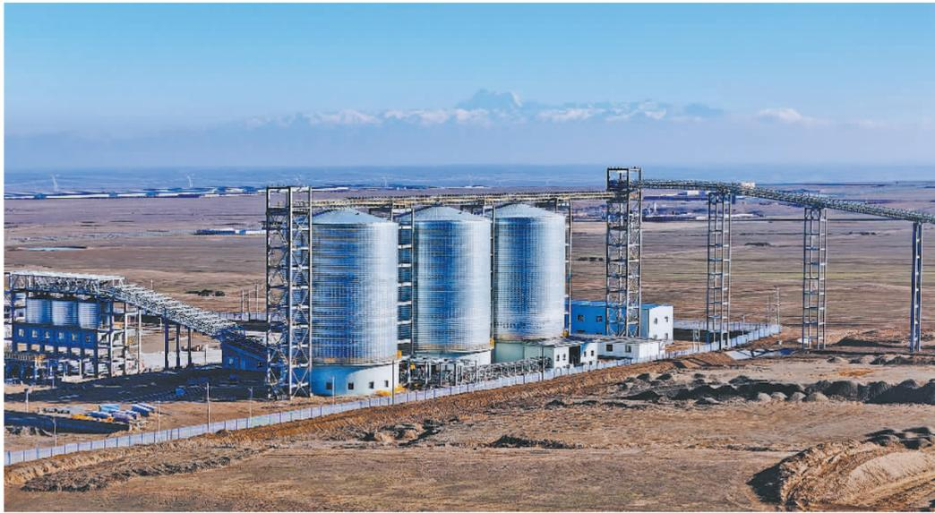
11月21日,工人在新疆昌吉回族自治州呼图壁县输煤廊道建设项目(一期)东线输煤廊道施工现场作业。该项目由输煤廊道和煤炭物流枢纽中心组成。其中,东线输煤廊道总投资4.998亿元,全长34.5公里。项目建成后,将由廊道取代车辆运煤,实现数字化、智能化管理,降低运输成本,改善沿线生态环境。陶维明摄(中经视觉)
