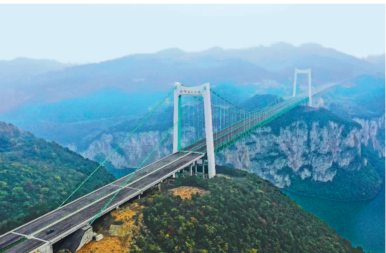
11月24日,车辆从贵金高速公路金峰乌江大桥上通过(无人机照片)。当日,贵阳金沙至古蔺(黔川界)高速公路(贵金高速)正式通车运营。贵金高速是国家高速公路网规划,贵阳至成都高速公路(筑蓉高速)的重要组成部分,主线全长165.28公里,对提升贵阳至成渝经济区交通运输能力,加快黔中经济区建设具有重大意义。新华社记者 杨文斌摄
