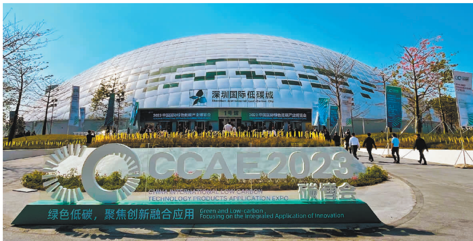
位于深圳国际低碳城的充气膜公共建筑“气膜馆”,具有建造快速、造型美观、场馆空间跨度大等特点
