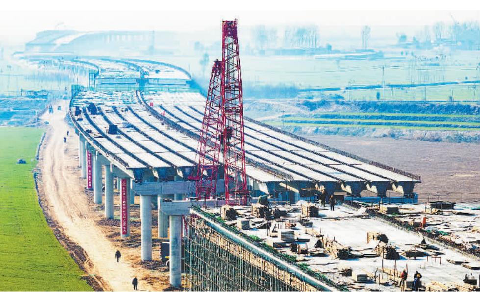
11月26日，河南省鹤壁市淇县西岗镇闫村附近，国道107京港线鹤壁境改线新建工程正在紧张施工。该工程全长约44.6公里，双向六车道，设计时速80公里，计划明年完成主体施工。王子瑞摄(中经视觉)
