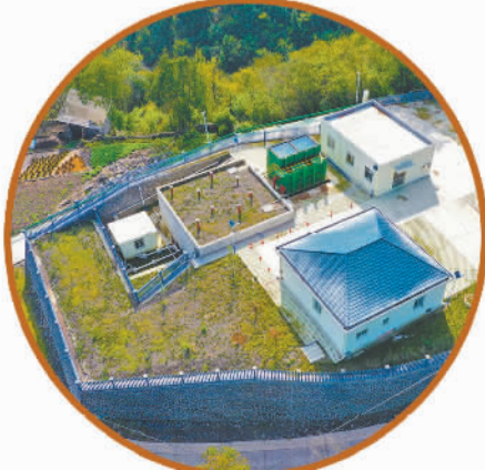
三斗坪镇饮水安全巩固提升工程
