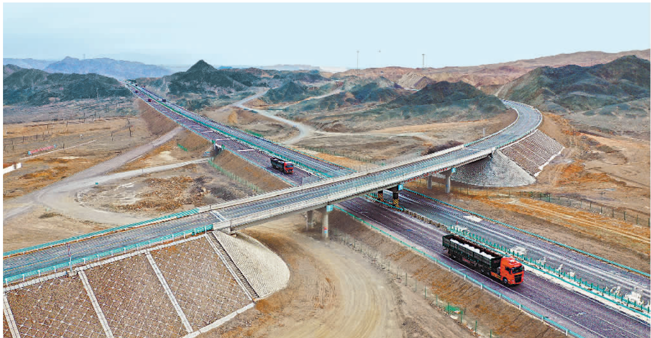
12月2日,新疆哈密首条“资源+能源+旅游”综合性干线S238红山口至十三间房公路正式通车,标志着哈密大外环公路网基本形成。该线路总里程为97.67公里,将为沿线矿产资源高效转运提供有力保障,并助力当地旅游业快速发展。
