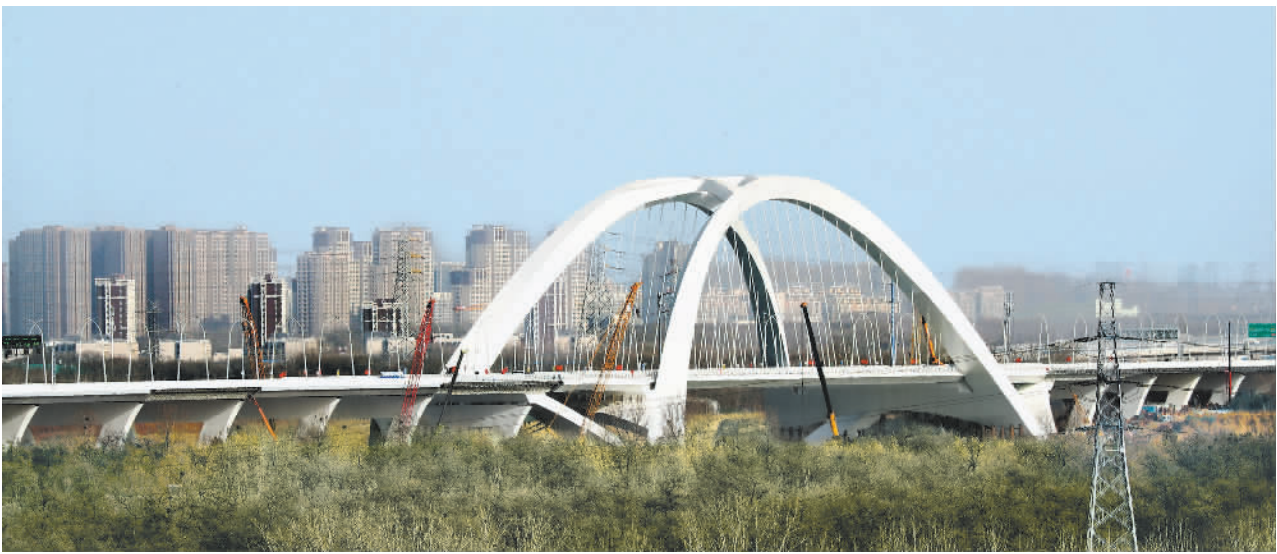
12月6日,京雄高速公路全线控制性工程——京雄大桥施工完成。京雄高速北京段预计年底开通,届时京雄高速将全线通车,京津冀交通一体化进程也将因此提速。周宇杰摄(中经视觉)
