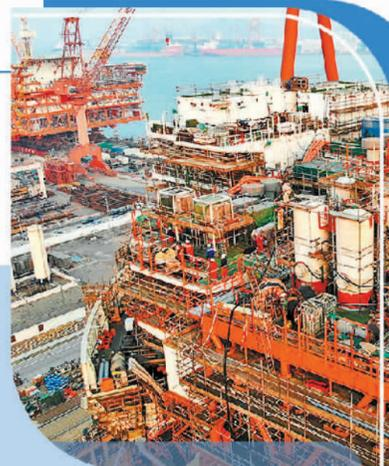
在海洋石油工程(青岛)有限公司生产基地，工人对“海洋石油122”进行上部模块总装作业。新华社记者 李紫恒摄
