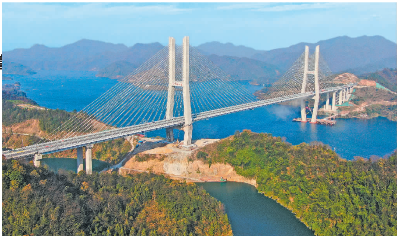
12月19日，湖南省官庄至新化高速公路正式建成通车。怀化、安化、常德、娄底等地公路系统实现互联互通，将更加方便当地群众出行，带动产业振兴，推动区域经济发展。
