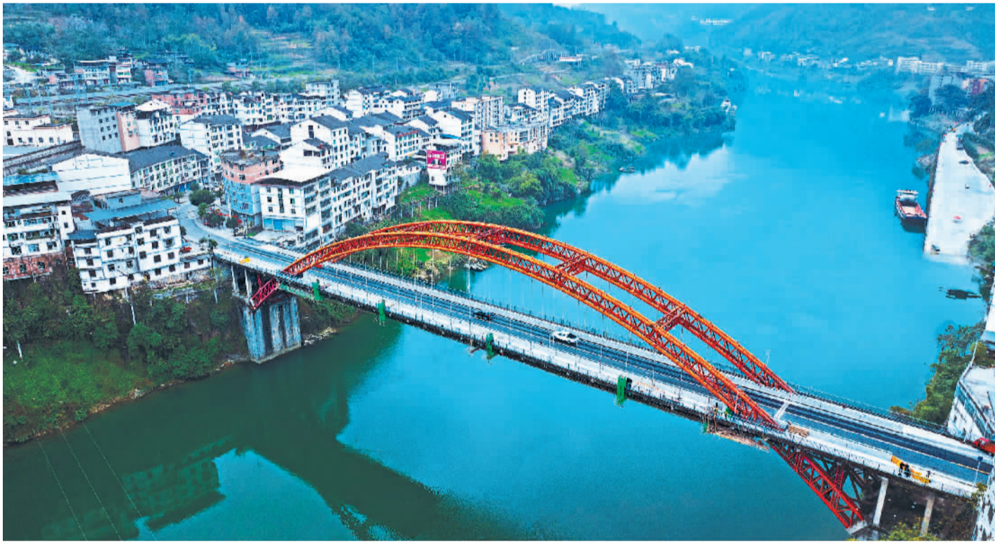
12月21日,位于重庆市彭水苗族土家族自治县的高谷乌江大桥维修改造工程全面完工,实现交通正常运行。今年年初,当地交通部门对该大桥进行全面检测并维修加固,全面排除安全隐患,保障桥梁安全通行。 赵勇摄(中经视觉)
