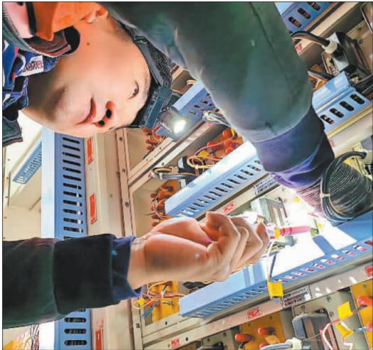
▲大秦铁路电务信号工调整信号设备电气特性参数，使之适应季节性温度、干湿度变化。
