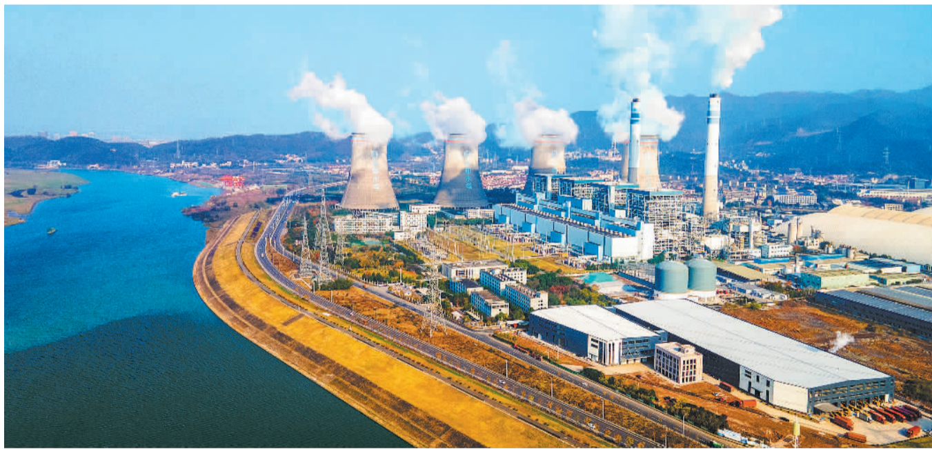
12月21日，浙江省最大内陆绿色电厂——浙能兰溪发电公司的4台机组正开足马力，确保发电供热稳定可靠。连日来，该公司机组负荷率达80%，每日发电量近5000万千瓦时，保障群众温暖过冬。胡肖飞摄(中经视觉)
