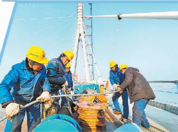
在中铁大桥局承建的常泰长江大桥施工现场，工人正在进行斜拉索架设相关工作。
