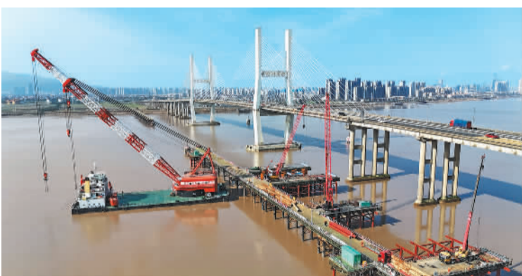
3月2日，甬台温高速公路温州大桥扩建工程建设现场，工人们正在进行桩基施工。该项目建设工期48个月，全线总体采用八车道高速公路标准改扩建，设计速度100公里/小时。蔡宽文摄(中经视觉)
