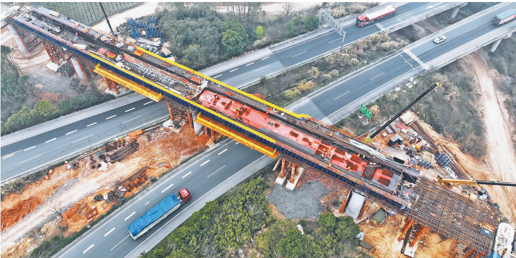
3月15日，新建京港高铁九江至南昌段（昌九高铁）庐山桥梁群首次成功跨越杭瑞高速公路。昌九高铁是我国“八纵八横”高铁主通道之一京港（台）通道的重要组成部分，建成后 will 加快推动江西对接融入粤港澳大湾区，促进沿线地区经济高质量发展。
