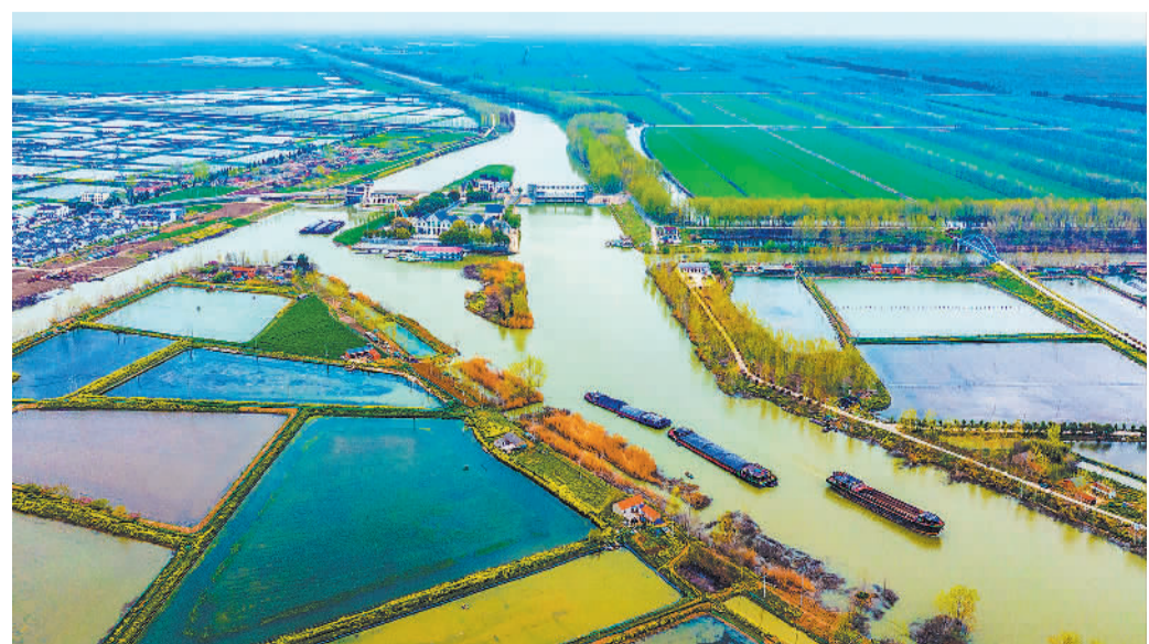
4月6日,江苏省宿迁市泗洪县半城镇淮河节制闸水利枢纽工程附近春意盎然。近年来,泗洪县统筹推进水资源、水环境和水生态治理,打造集行洪供水、交通旅游、水上航运于一体的枢纽工程,方便群众生产生活,促进地方经济发展。 张连华摄(中经视觉)
