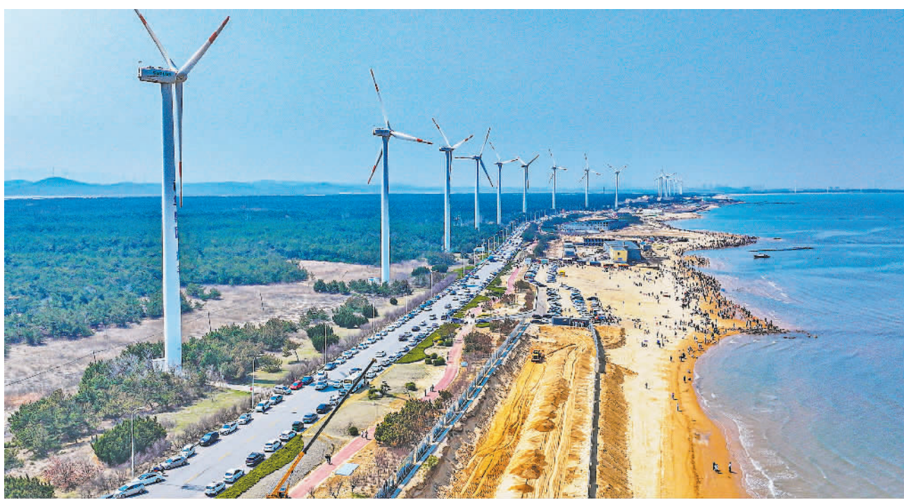
山东省荣成市好角旅游度假区北部沿海风电场，“风电长廊”风景如画。近年来，荣成市充分依托沿海自然优势和丰富的风能资源，大力发展风力发电产业，有力推动了当地经济高质量发展。 李信君摄(中经视觉)
