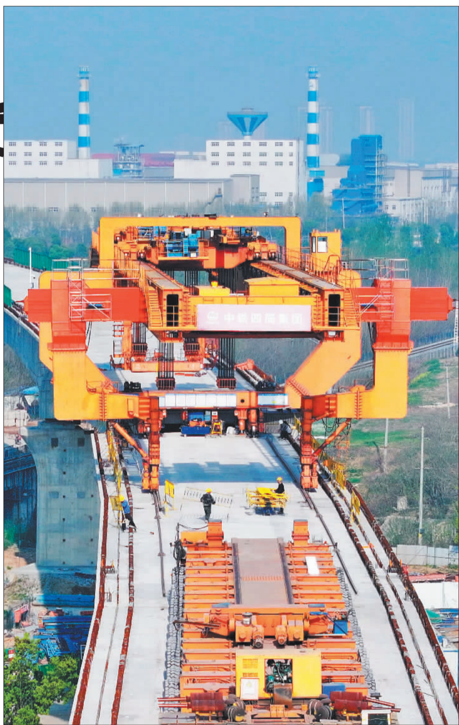
▲4月1日,合新高铁建设现场,工人正在进行机械化架梁作业。合新高铁由安徽合肥至江苏新沂,全长343.5公里。 张敏摄(中经视觉)
