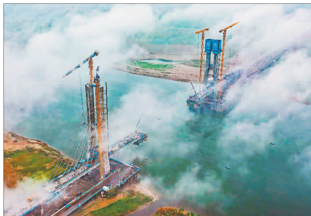
▼4月2日,沪渝蓉高铁钟祥汉江特大桥西岸边跨成功合龙,标志着世界最大主跨的高速铁路无砟轨道混凝土梁斜拉桥实现首个边跨合龙。 古建教摄(中经视觉)
