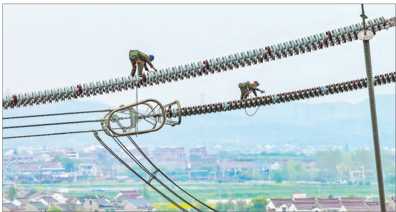
▼4月7日,江苏省南京市±800千伏建苏线检修现场,检修人员在高空对线路进行检修作业,保障特高压电网安全稳定运行。 史俊摄(中经视觉)
