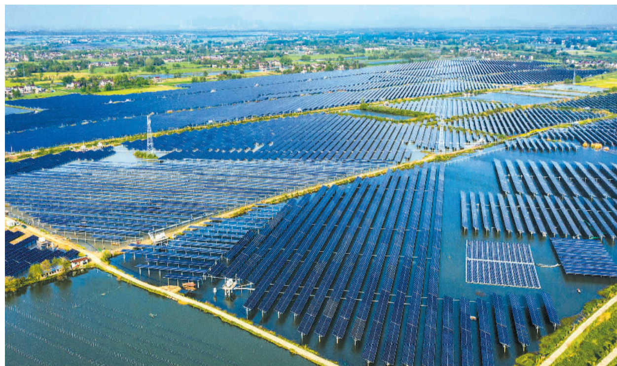
4月9日拍摄的安徽省铜陵市枞阳县汤沟镇连片的发电板。近年来，该县依托当地光照条件优势，大力发展“渔光互补”光伏发电项目，将光伏发电和渔业养殖相结合，促进经济、生态双丰收。
