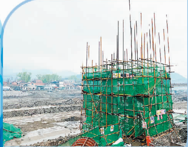
北京房山区河北镇磁家务村大石河左岸的自计井已完成浇筑，目前正在养护阶段。本报记者 潘卓然摄
