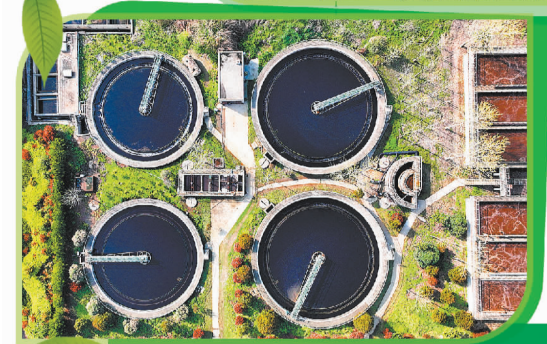
下图 江苏省海安市孙庄街道通学桥村工业废水治理设施一角。顾华夏摄(中经视觉)
