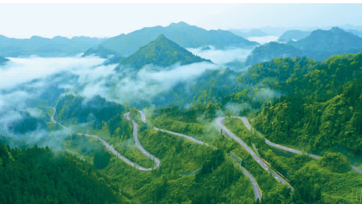
4月22日,重庆市酉阳土家族苗族自治县至湖北省来凤县的省道305公路,蜿蜒盘旋在山间。近年来,当地大力推进交通基础设施建设,优化城乡路网布局,方便群众出行,助力沿线经济社会发展。段成军摄(中经视觉)
