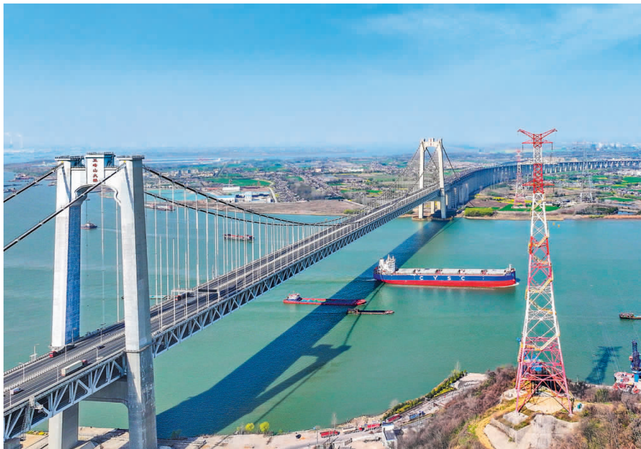
4月28日,我国首个“交改直”输电工程——扬州至镇江±200千伏直流输电工程正式竣工投运,将显著提升长江两岸电网互联互通能力,满足长三角地区清洁能源优化配置需求。图为输电工程长江段。
