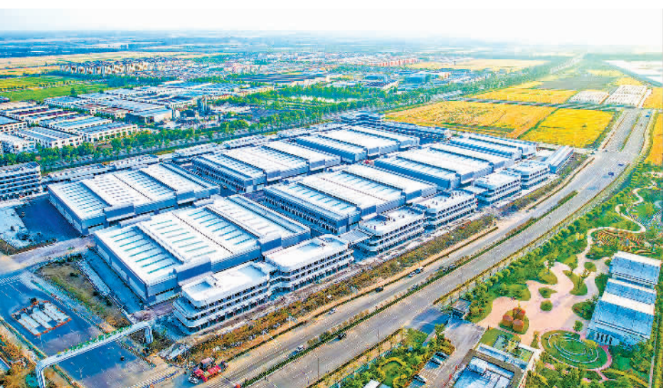
位于江苏省宿迁市宿豫区新庄镇的中国农批宿迁现代农产品物流园，总占地面积506亩，项目正在加紧建设。陈少卿摄(中经视觉)
