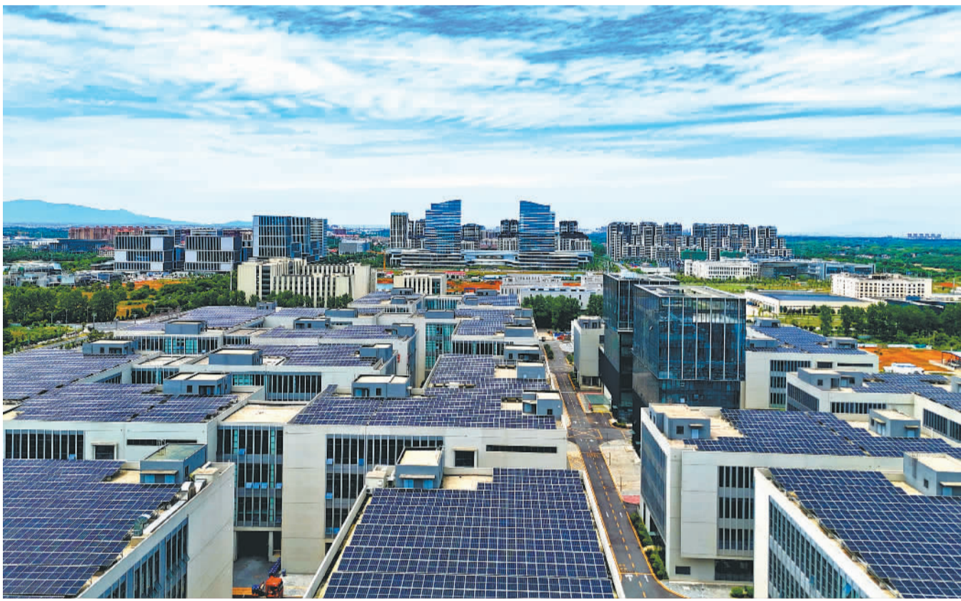
6月3日,江西省赣江新区中医药科创城创新示范基地,一排排太阳能光伏组件源源不断产生清洁能源。近年来,赣江新区鼓励企业利用厂房、办公楼推进屋顶光伏发电项目建设,为低碳发展注入清洁能源。
