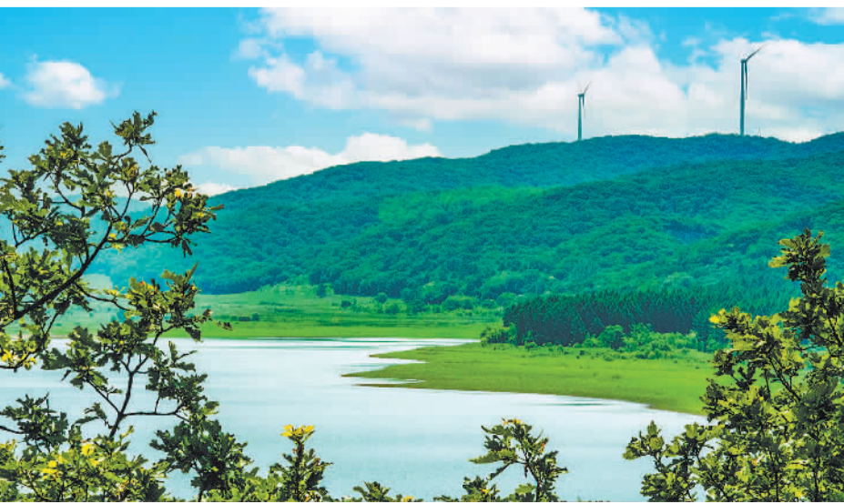
吉林省四平市塔子山上的风力发电设备正在运行。近年来，当地积极推进绿色新能源项目建设，为经济发展和民生改善增添动力。吕昊俊摄(中经视觉)
