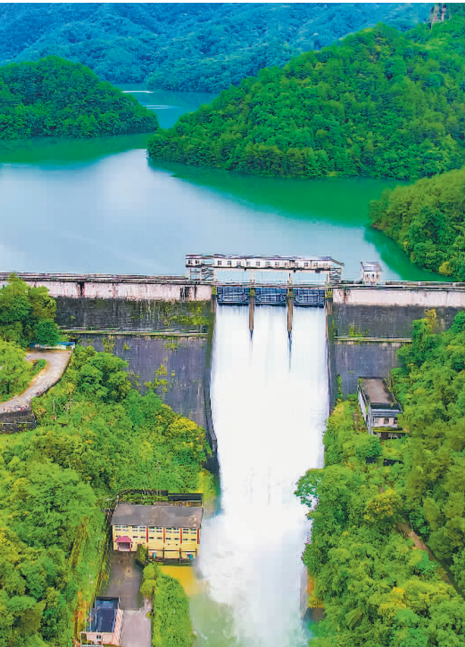
6月18日,广西梧州市蒙山县茶山水库开闸泄洪。连日来,持续降雨导致河流水位上涨,当地启动洪涝灾害四级应急响应,全力保障人民群众生命和财产安全。周火文摄(中经视觉)
