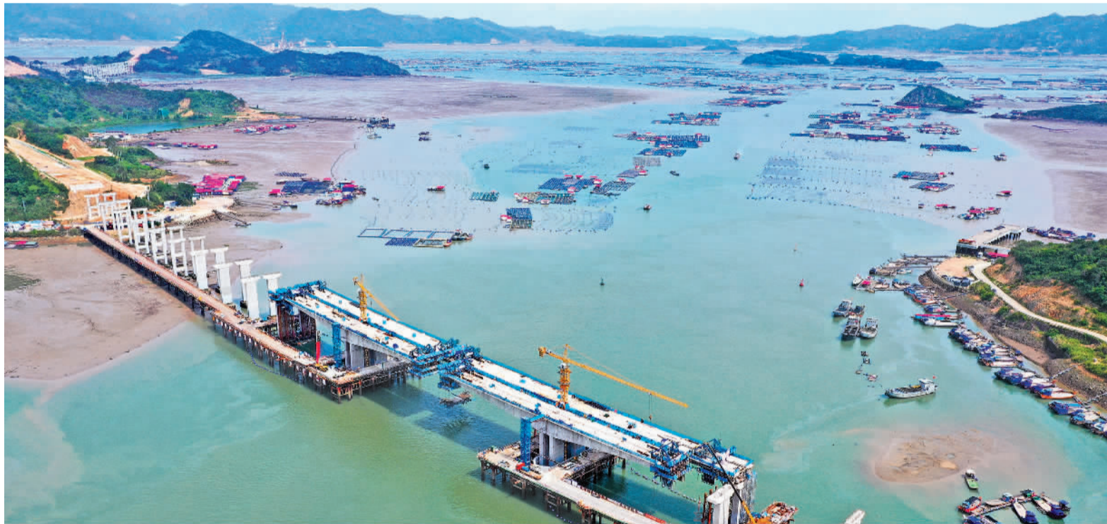
6月21日，位于福建省霞浦东安岛的宁上高速项目A2标段关门跨海大桥正加紧施工。该项目建成后，将有利于进一步完善闽东高速公路网络，促进闽东经济发展。 王旺旺摄 (中经视觉)
