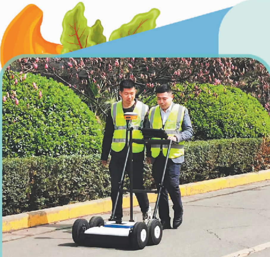
西安远诺率线员明科技有限公司与西安电子科技大学团队,成立了中创云图科技有限公司。图为中创云图科技有限公司研发人员用探地雷达对道路进行检测。刘倩摄(中经视觉)
