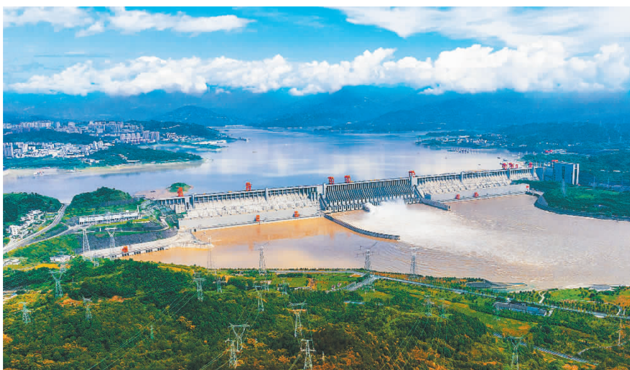
7月30日，在湖北宜昌拍摄的三峡电站外送输电线路。随着由乌东德、白鹤滩、溪洛渡、向家坝、三峡、葛洲坝6座梯级水电站构成的世界最大清洁能源走廊110台机组全开运行，截至7月23日，2024年梯级水电站单日发电量超10亿千瓦时天数达35天，最高单日发电量达15亿千瓦时，全力协助电网迎峰度夏。 郑家裕摄（中经视觉）
