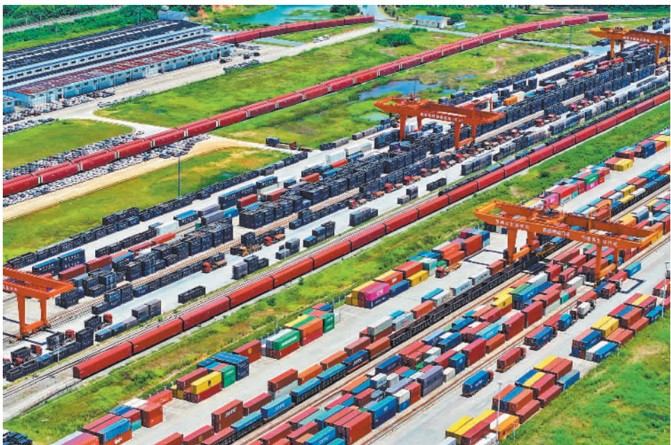
7月31日，位于江西省南昌市南昌县向塘镇的南昌国际陆港货运站，龙门吊在装运进出口货物集装箱，一派繁忙有序的景象。近年来，南昌国际陆港大力发展中欧班列、铁海联运班列，目前已覆盖欧洲、美洲、东南亚等30多个国家和地区。 朱海鹏摄（中经视觉）
