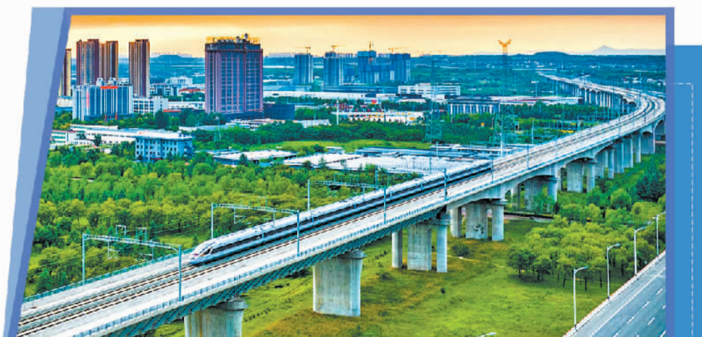
“复兴号”动车组列车从位于陕西西安的银西高铁渭河特大桥上飞驰而过。 刘翔摄(中经视觉)
