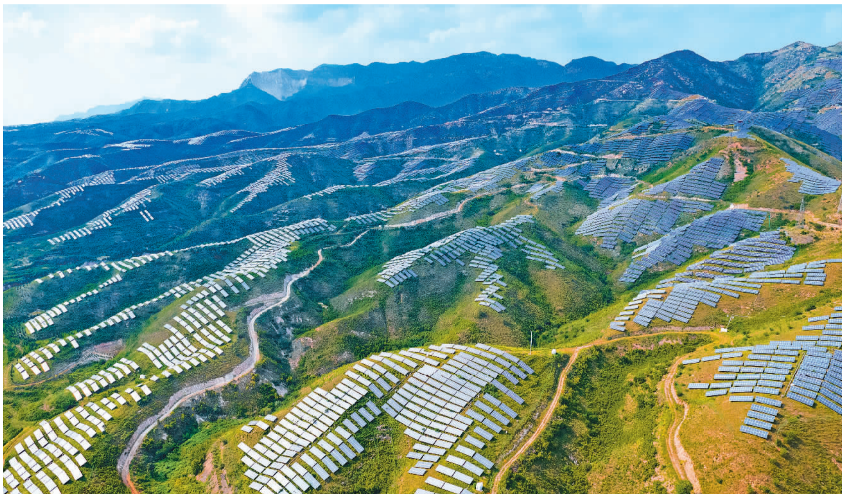
9月7日，位于山西省运城市稷山县西社镇的一处光伏电站，一排排光伏板正源源不断输送绿色能源。近年来，当地不断优化能源供给结构，因地制宜推进光伏发电绿色经济产业发展，实现生态保护和可持续发展。常奇摄（中经视觉）
