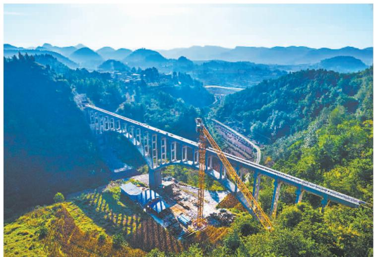
9月19日，建设中的贵州夹岩水利枢纽工程毕节市黔西市境内横跨两山的拱桥渡槽。该工程是以城乡供水和灌溉为主、兼顾发电，建成后将有助于解决黔西北地区缺水问题。
