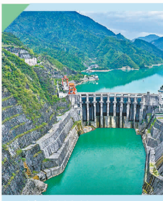
图为乌江彭水水电站大坝。
