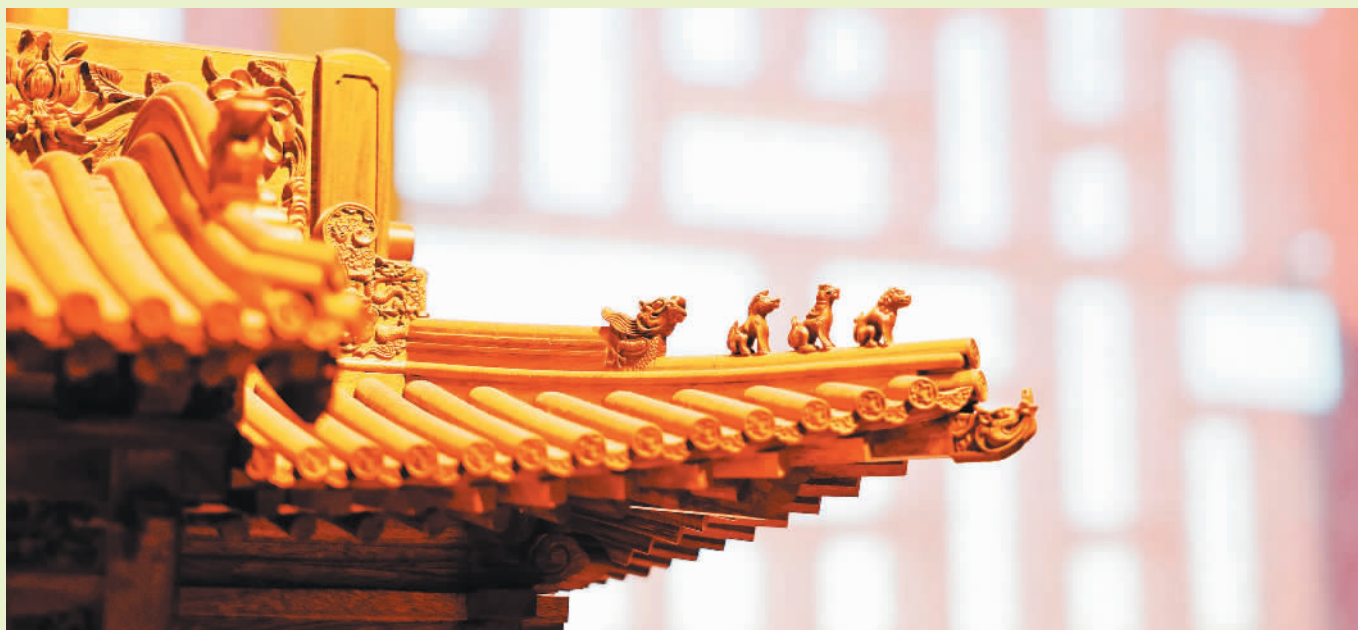
▼11月7日,国家级古建筑模型制作技艺非遗传承人祁伟成在展示不同朝代的斗拱。斗拱通过榫卯之间纵横交错组合,在不使用一根金属连接件的情况下,让建筑可以屹立千年。
