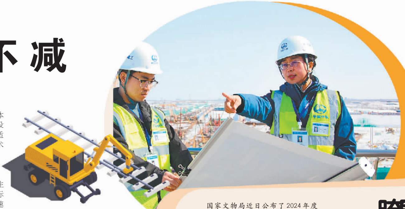
许慧（右）在施工现场进行技术指导。张权摄（中经视觉）
