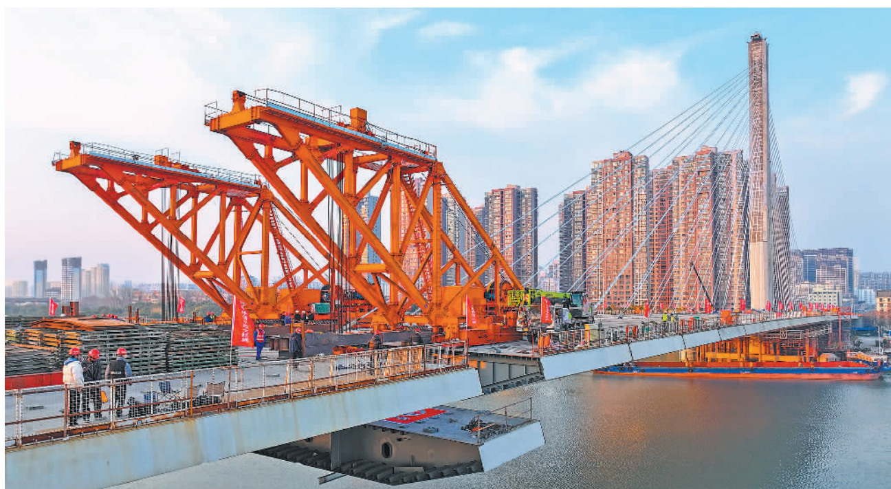
12月24日拍摄的京杭运河沔阳桃源大桥合龙现场。大桥建成后,将成为千里运河上跨径最大、主塔最高的悬索斜拉桥,极大改善现有过河通道交通压力。方东旭摄(中经视觉)
