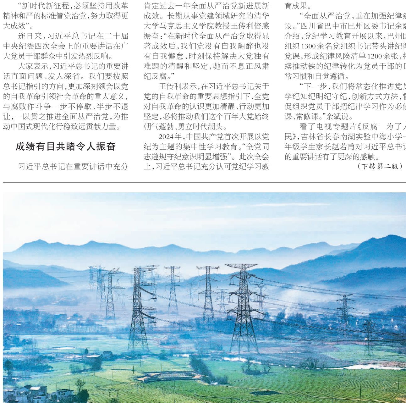
1月8日拍摄的安徽省芜湖市“西电东送”特高压通道工程。吉泉±1100千伏等多条特高压输电工程经过芜湖境内，将我国中西部地区电能输送到华东地区。 鲁君云摄(中经视觉)
