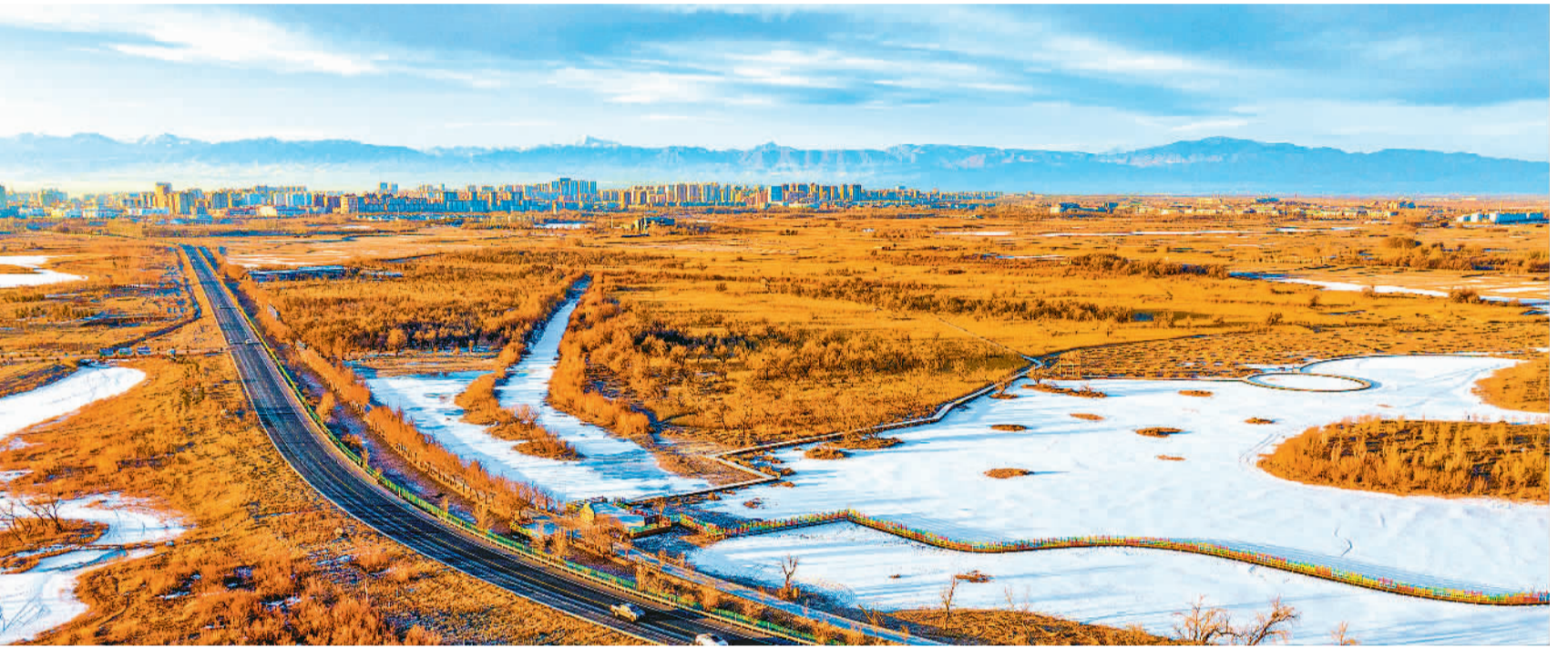
1月18日,甘肃省张掖市甘州区三闸镇二闸村的“四好农村路”串起乡村冬日美景。近年来,当地把农村公路建设作为巩固脱贫攻坚成果、助推乡村全面振兴的重要抓手,为经济社会发展提供有力支撑。
